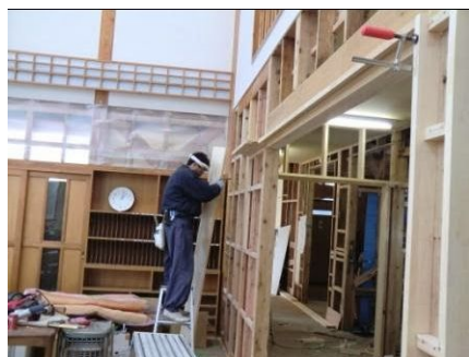
新生釜石教会修復工事中！
