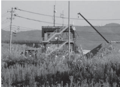
南三陸町旧防災対策庁舎
